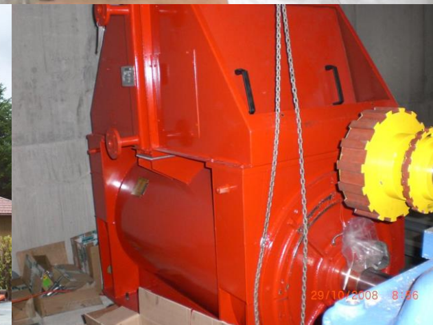
Von oben links im Uhrzeigersinn: 1. Baggerarbeiten am Steilhang; 2. Einbau der Mauerdurchführung der Druckleitung; 3. Einbau des Generators; 4. Anlieferung der Turbine
