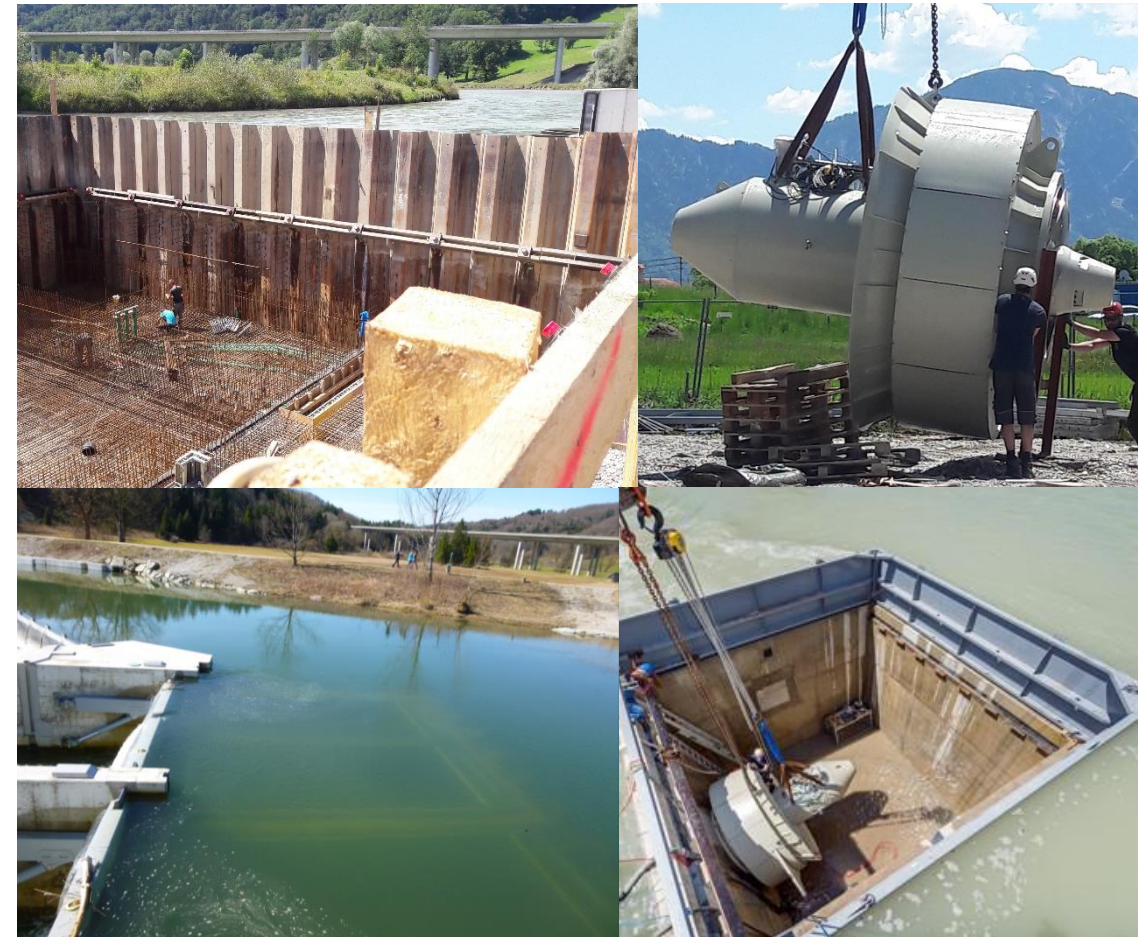
Oben von links im Uhrzeigersinn: 1. Betonierarbeiten Schacht 07/2018; 2. & 3. Einheben der Turbine 06/2019; 4. horizontale Rechenebene und aufgestellten Wehrklappen
