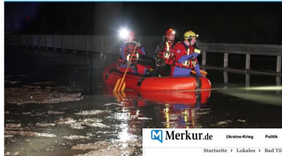
Wassermassen überfluten einen Tunnel an der B23 bei Bad Saulgrub. Foto mit Booten und Tauchern im Einsatz.
